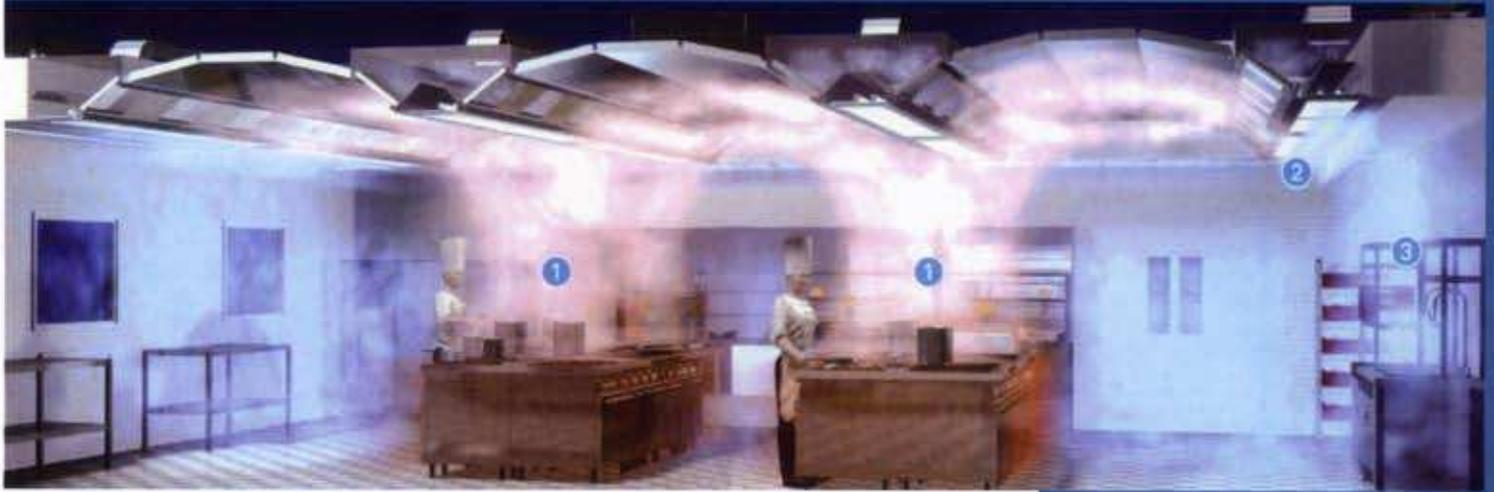
Die in der Küche entstehenden Kochwrasen enthalten luftfremde Stoffe, wie z.B. Feststoffe, Fettdämpfe, Wasser und Geruchstoffe. Diese (1) steigen als Thermikstrom zur Küchenlüftungsdecke auf.
